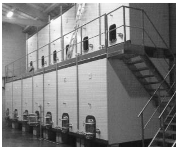
Batería de depósitos de hormigón en una bodega.
