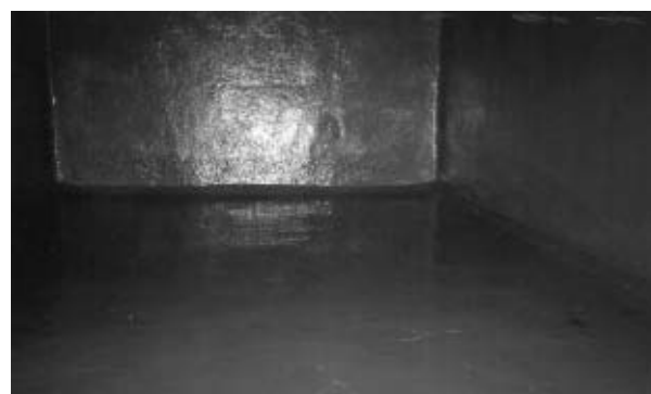
Interior de un depósito de hormigón armado revestido con resina epoxy.
