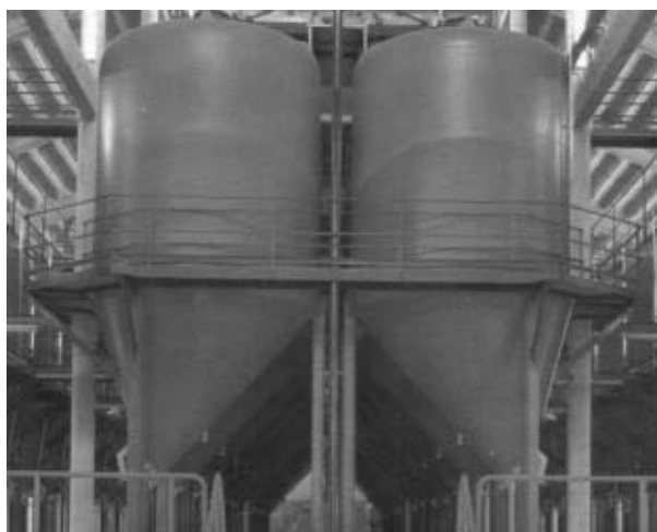
Depósitos de acero al carbono autovaciantes sobre patas revestidos interiormente con esmalte vitrificado.
