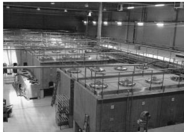
Bodega con depósitos aéreos de hormigón.
